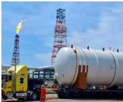
FA-88101 Tanque Recibidor de Amina
