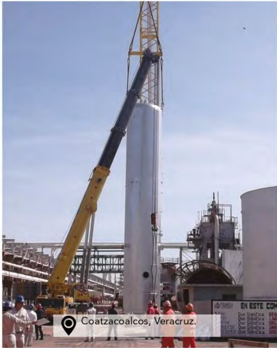
COLUMNA D-115 PLANTA DE ÓXIDO DE ETILENO CHEMISA S.A. DE C.V.
