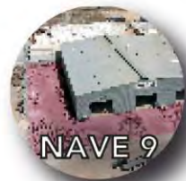
NAVE 9 Fabricación de Recipientes a Presión Área: 1,560 M 2
