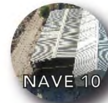
NAVE 10 Aplicación de Sandblast y Pintura Área: 1,100 M 2
