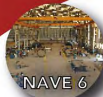
NAVE 6 Fabricación de Recipientes a Presión y Torres de Proceso Área: 2,400 M 2
