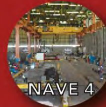
NAVE 4 Corte, Habilitado y Rolado para Tanques Tipo API Área: 1,344 M 2
